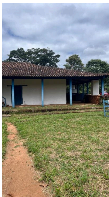
Fachada lateral da sede da Casa Autoria: Natália Morita Data: 25/02/2025
